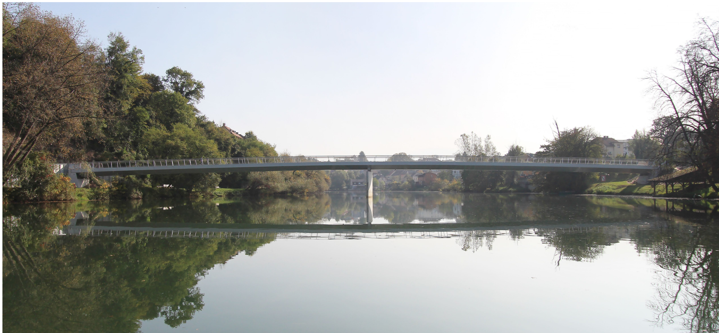
Primer dobre prakse: Julijin most za pešce preko reke Krke v Novem mestu, razpon 2 x 57 m, avtor - projektant Marjan Pipenbaher
