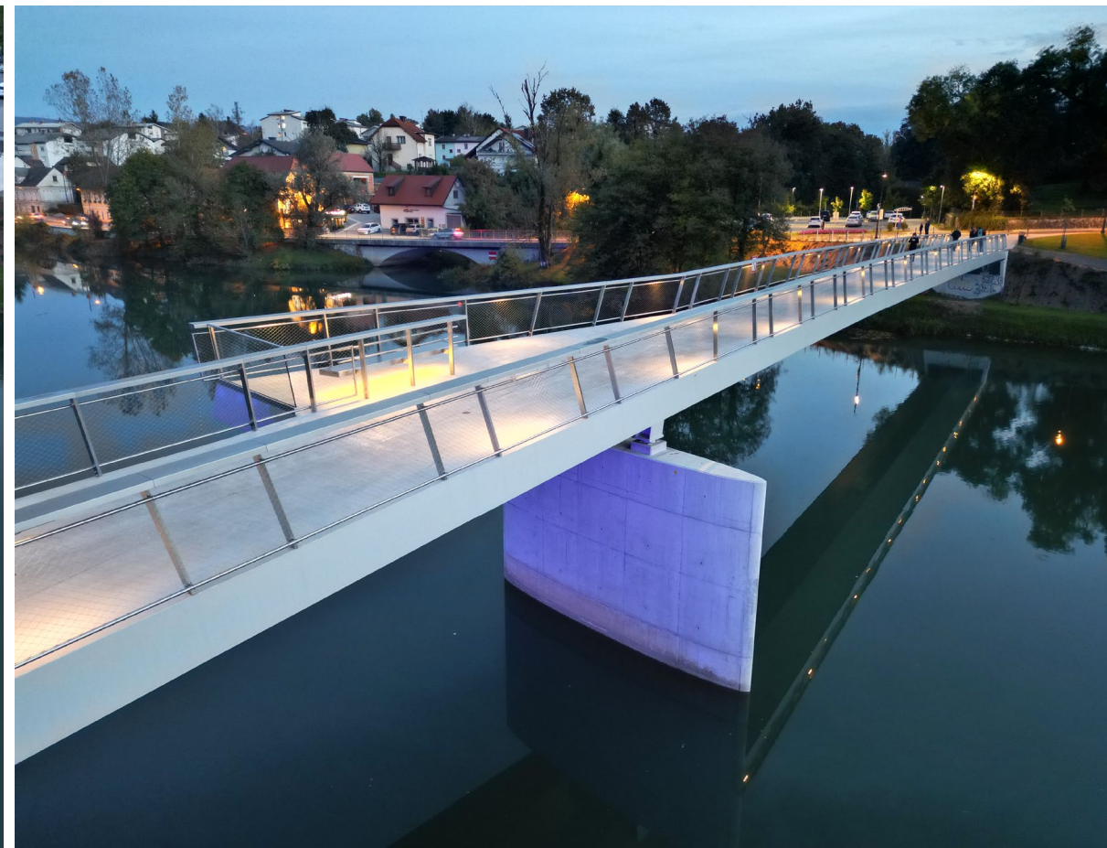
Primer dobre prakse: Julijin most za pešce preko reke Krke v Novem mestu, razpon 2 x 57 m, avtor - projektant Marjan Pipenbaher
