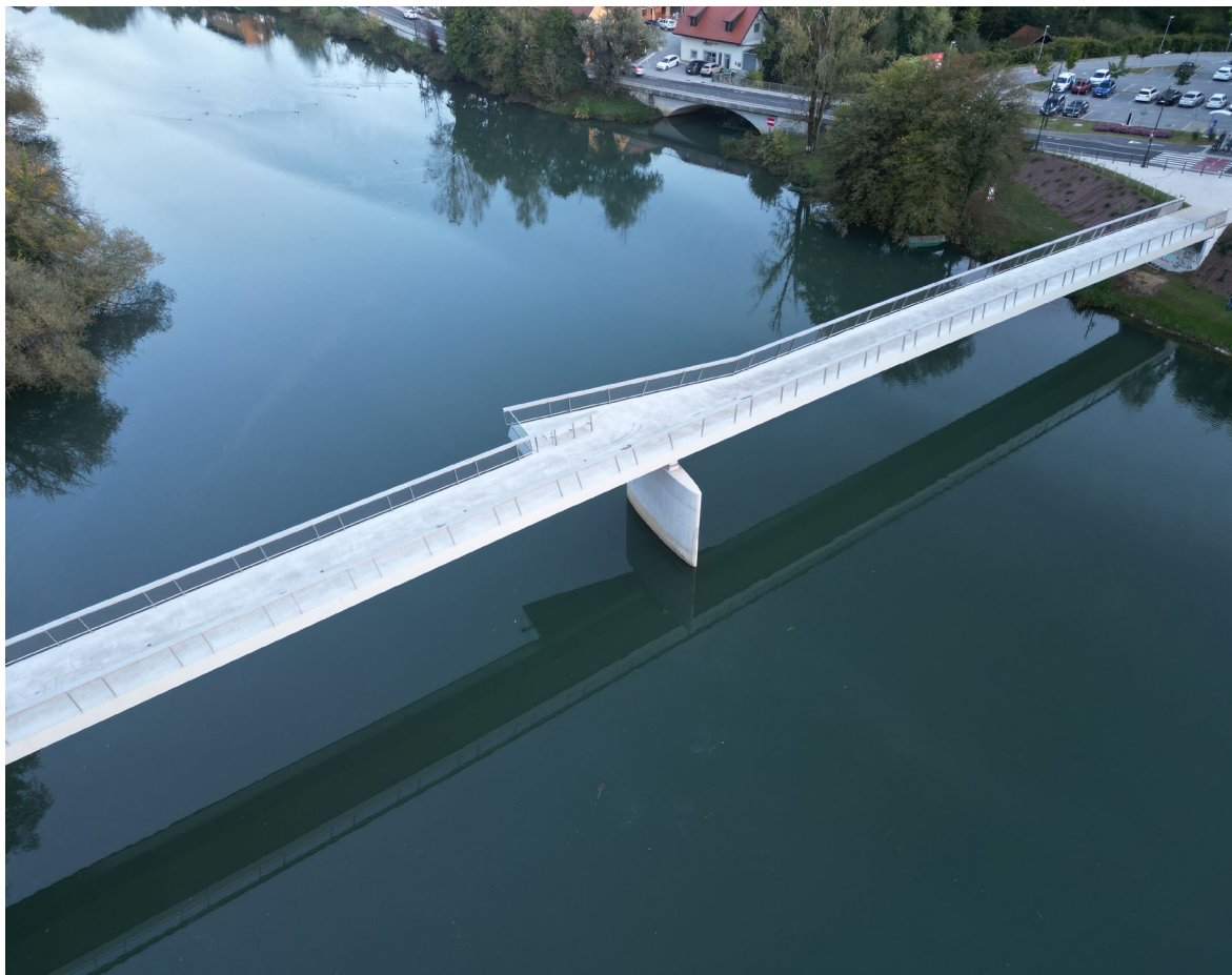
Primer dobre prakse: Julijin most za pešce preko reke Krke v Novem mestu, razpon 2 x 57 m, avtor - projektant Marjan Pipenbaher
