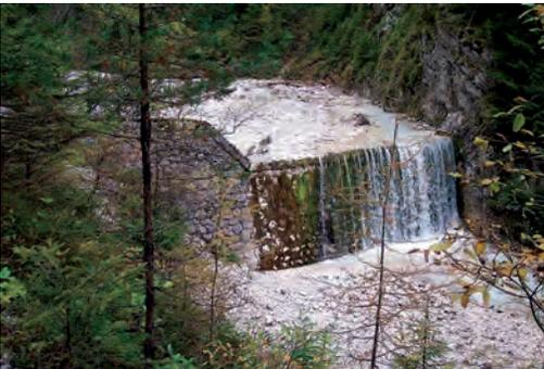
Abb. 1: Mehr als 50 Jahre alte Wildbachsperre aus Stein in Zementmörtel (Wildbach Martuljek)
