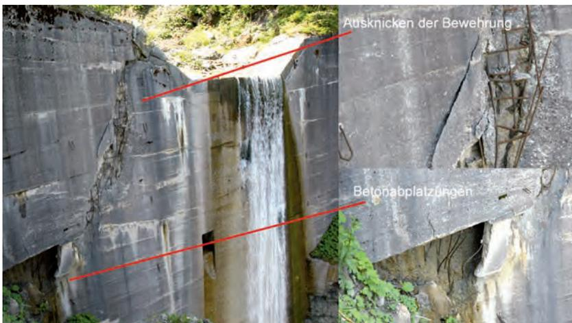
Abb. 14: Hangdruck: Versagensmechanismus 2 (lokales Druckversagen): lokales Druckversagen des Betons mit ausgeknickten Bewehrungsstäben und Betonabplatzungen.
