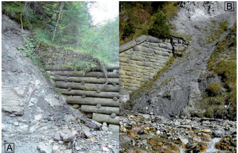
Abb. 10: Seitlicher Flankenwiderstand: (A) fehlender Flankenwiderstand bei einer Holzkastensperre (Mechanismus 1); (B) Flächenerosion (Mechanismus 3)
