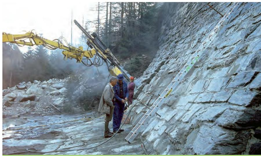
Abb. 3: Bohren und Injizieren des Sperrkörpers
