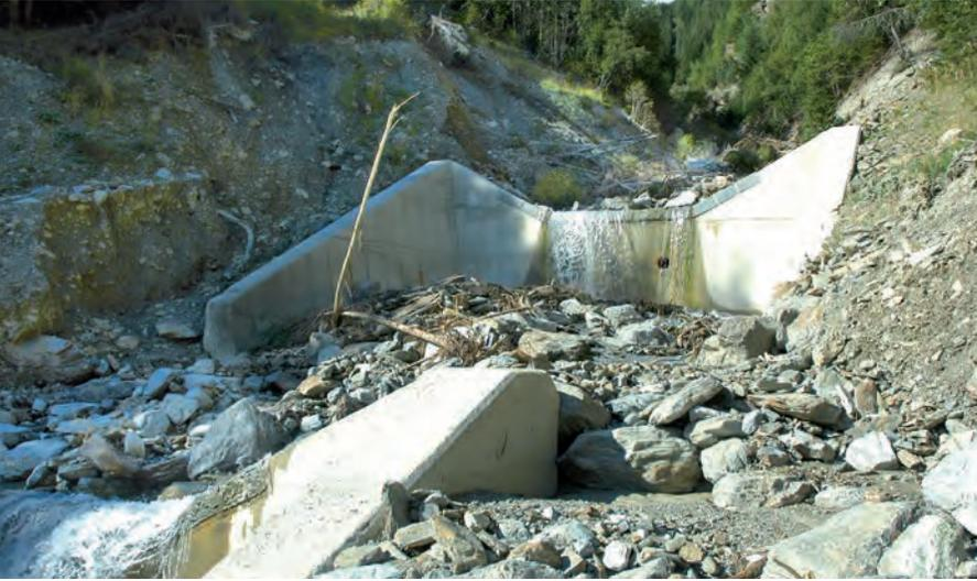
Abb. 2: Besonders nach extremen Naturereignissen kann die Standsicherheit und Funktionsfähigkeit von Schutzbauwerken sprunghaft abnehmen, entsprechende Bedeutung hat eine anlassbezogene Zustandserfassung und Ableitung (Realisierung) der erforderlichen Instandsetzungsmaßnahmen, um das Sicherheitsniveau zu erhalten.
