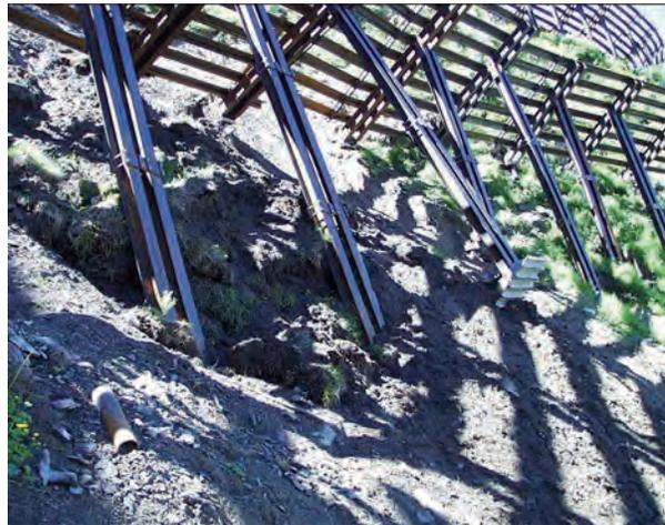
Abb. 5: Schäden an Stützenfundamenten durch überhöhte Bodenpressung
