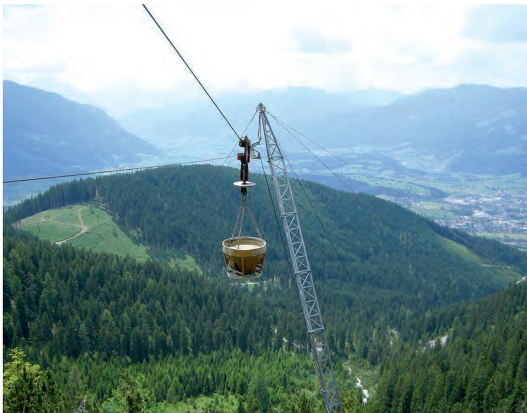
Abb. 7: Erschließung der Baustelle durch eine 1.100 lfm lange Materialeilbahn
