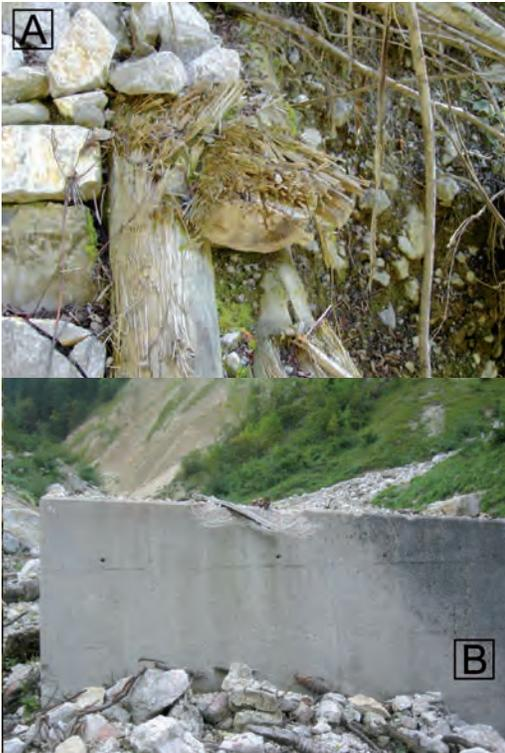
Abb. 4: Abrasion mit hohem schlagendem Anteil: (A) Hydroabrasion auf Holz; (B) Abrasion einer Stahlbetonkrone im seitlichen Flügelbereich
