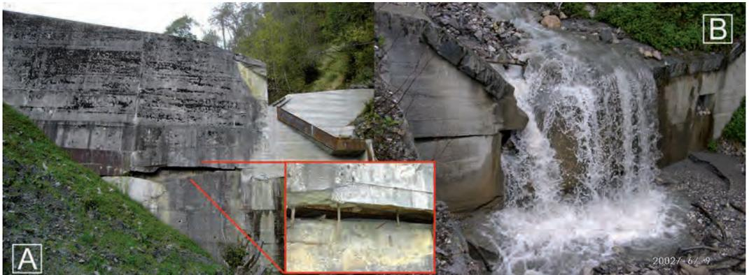
Abb. 13: Hangdruck: Versagensmechanismus 1 (Schubversagen): (A) Abscheren des Flügels an einer horizontalen Fuge (Trennriss) mit anschließender Verkantung; (B) Abscheren mit Verkantung und Verdrehung
