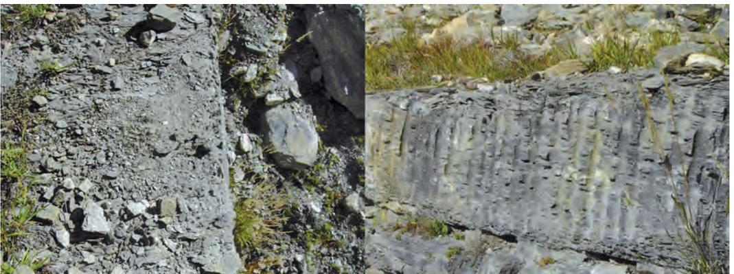
Abb. 28: Frostverwitterung an einer Sperrkronen
