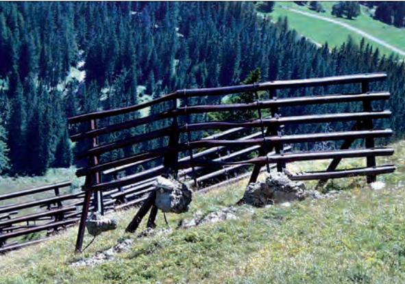
Abb. 2: Seitliche Lawinenwirkung führt häufig zu Schäden an Randwerken
