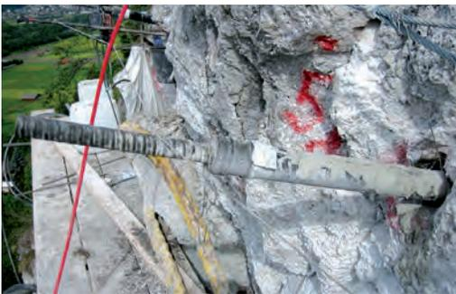
Abb. 8 und 9: Eingebauter Einstabanker und Spannvorgang mittels Presse
