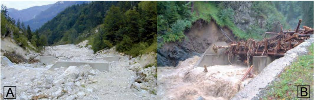
Abb. 11: Umgehung: (A) Umgehung aufgrund Anlandung und zu geringer seitlicher Einbindung; (B) Umgehung aufgrund Verklausung des funktionalen Teiles und fehlender seitlicher Einbindung (Foto: Walser Otto)
