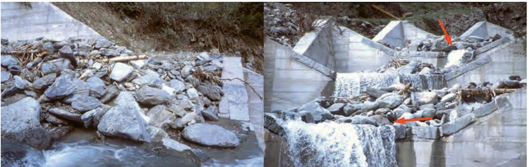
Abb. 12: Auflandung im wasserseitigen Sperrenvorfeld und Verlagerung der Bachachse an den Gewässerrand
