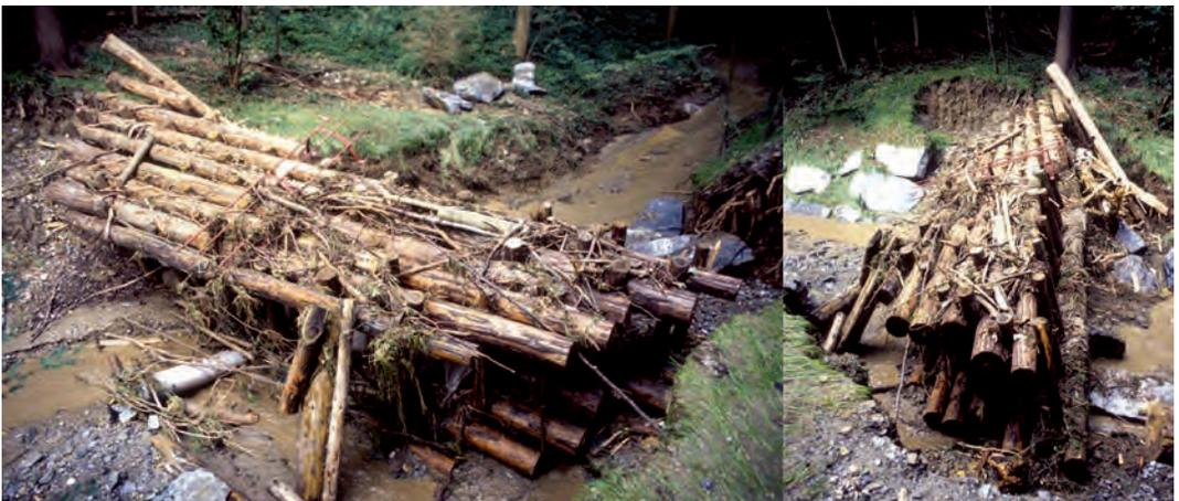
Abb. 15: Auftriebsbruch: aufgeschwommene und gekippte Holzkastensperre
