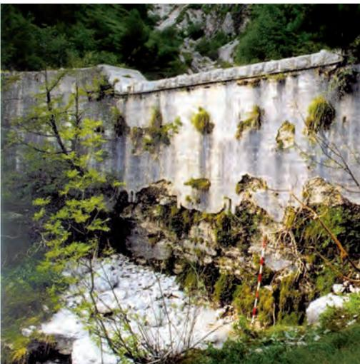
Abb. 5: Beschädigte Betonsperre (Wildbach Prekopa)
