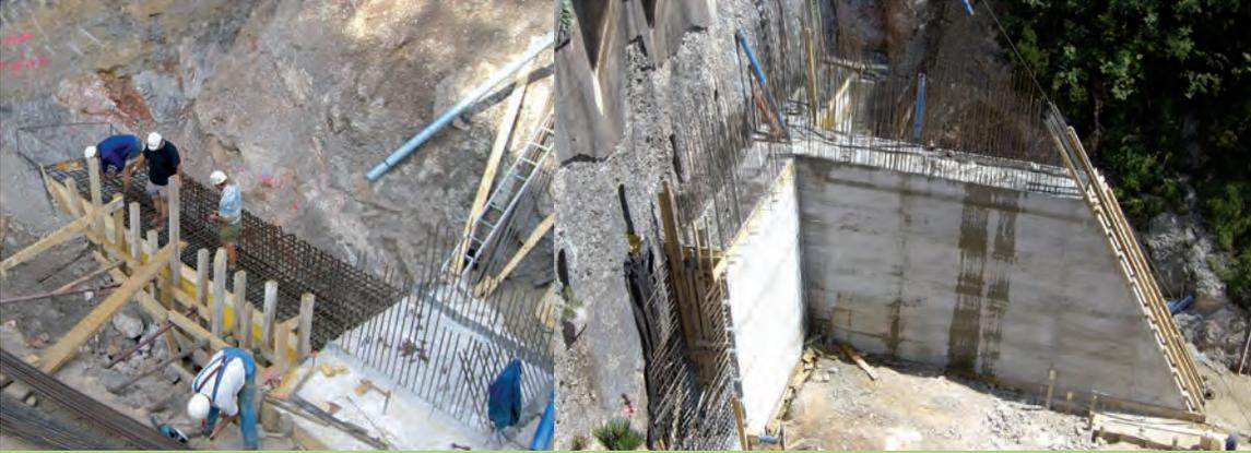
Abb.8: Abschnittsweiser Aushub bzw. Unterfangung im Mittelteil der Haidensperre
