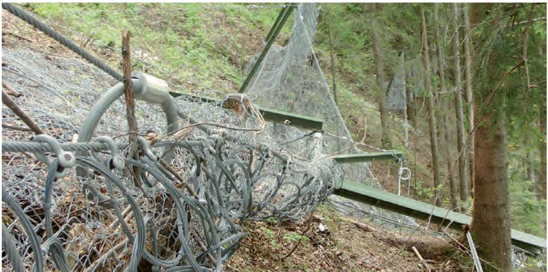
Abb. 2: Beschädigtes Steinschlagnetz (Quelle: Dirninger, 2006).
