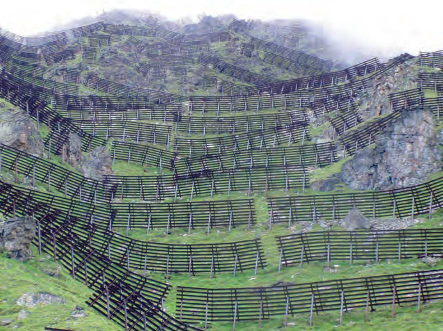
Abb. 1: Lawinestützerwerke werden im extremen Gelände errichtet und sind außergewöhnlichen Umgebungsbedingungen und Einwirkungen ausgesetzt, Schäden an der Verankerung und dem Oberbau aufgrund extremen Schneedrucks treten immer wieder auf: Entsprechend wichtig ist die laufende Überwachung der Anlagen und die rasche Durchführung erforderlicher Instandhaltungsmaßnahmen.
