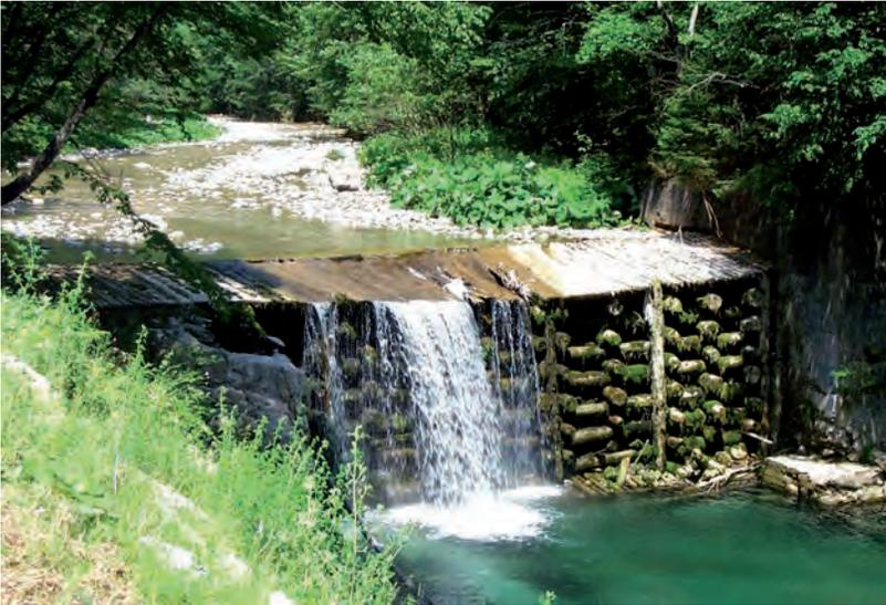
Abb. 4: Beschädigte Steinkastensperre (Wildbach Kokra)
