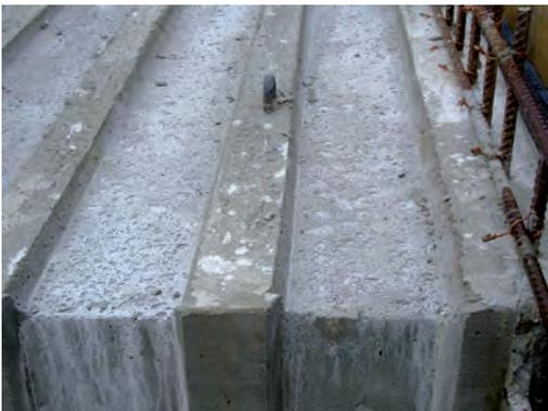
Abb. 9: Fugenausbildung (Arbeitsfugen) mit Verzahnung gemäß ÖN B4700
