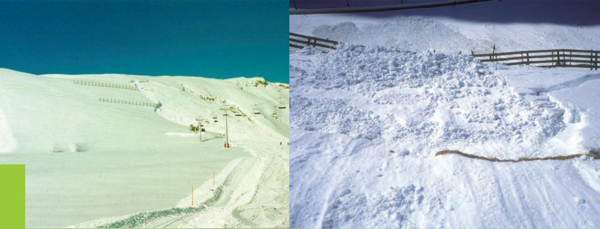
Abb. 6: Lawinenanbruch neben einer Verbauung mit Schneenetzen im Skigebiet von Grindelwald (Photo H. Buri, Amt für Wald, Interlaken) sowie in einer Stützverbauung am Oberalppass
