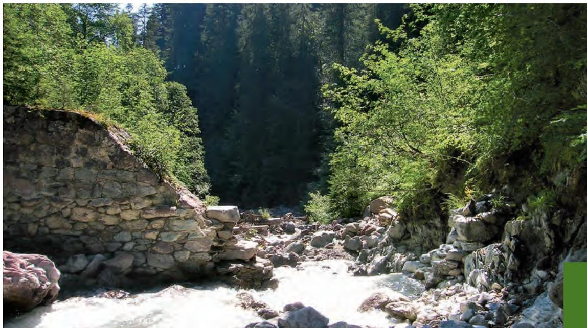
Abbildung 7: Zerstörung der Abflusssektion Rellsbach
