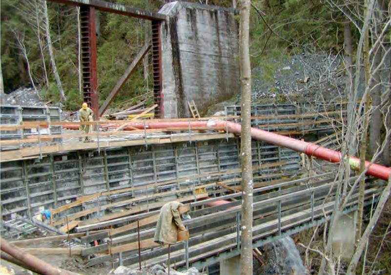
Abb. 4: Die Bogensperre wurde mit einer durchgehenden Stärke von 1,0 m vorbetoniert und hinsichtlich der Einbindung in den anstehenden Fels gegenüber dem Altbestand wesentlich verbessert.
