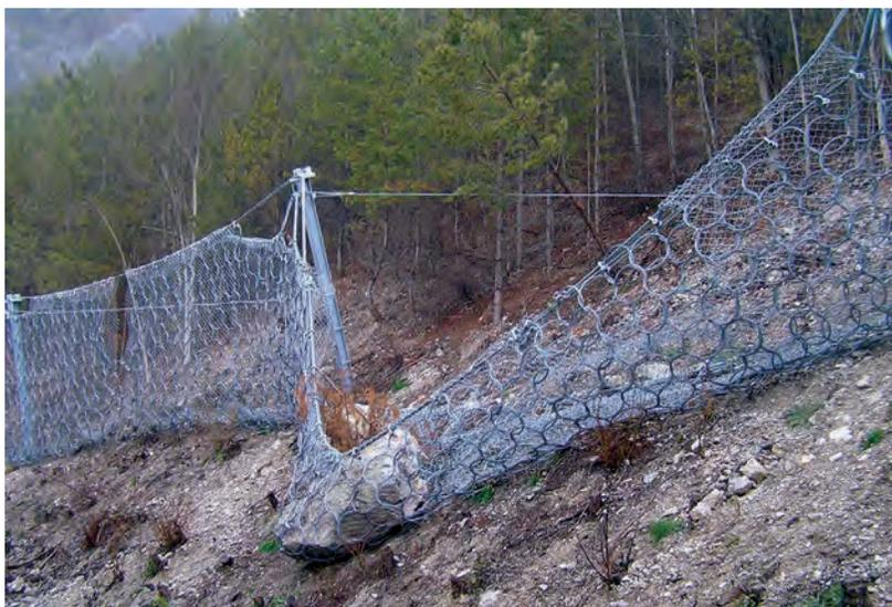
Abb. 7: Steinschlagschutznetz nach Beaufschlagung
