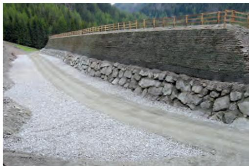
Abb. 2: Mit dem kombinierten Steinschlagschutzdamm (Steinschichtung mit aufgesetzter bewehrter Erde) und einem dämpfenden Fallboden wird der Schutz für ein Gewerbegebiet erreicht
