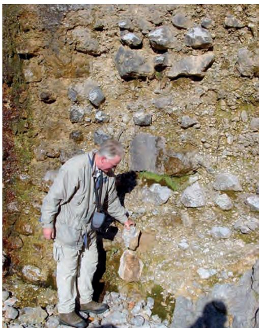
Abb. 3: Im Mittelteil der Sperre lösen sich die Steine aus dem Betongefüge
