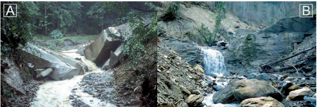
Abb. 18: Zerstörung von Sperren: (A) Totalschaden; (B) Zerstörungen der Sperrenkrone mit anschließender Abrasion des Sperrenkörpers
