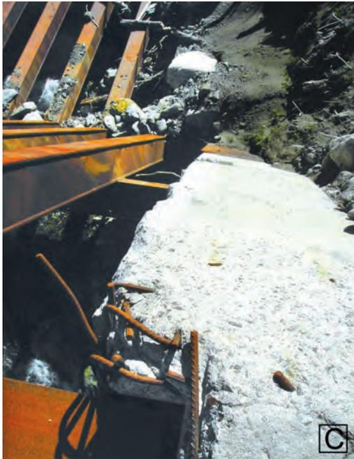
Abb. 4: Schäden an Wildbachsperrn: (C) Reduktion der Dauerhaftigkeit durch Abrasion der Betondeckung und Bewehrungskorrosion
