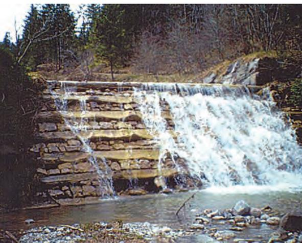
Bild 1: Durch Geschiebetrieb bereits deutlich angegriffene Sperre; die Unterhaltung kann da nicht mehr lange warten.
