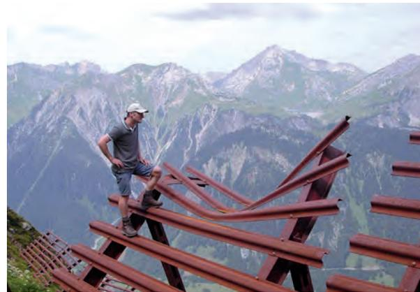
Abb. 3: Schäden an den obersten Balken durch Schneedruck
