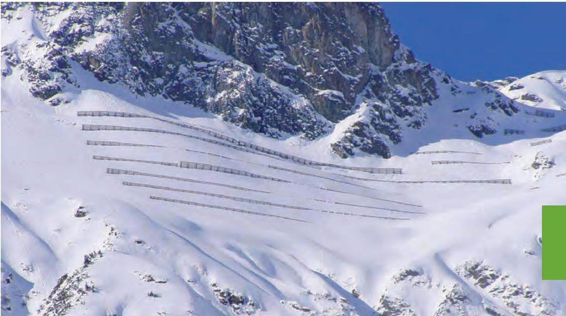
Abb. 1: Großtallawine, Gde Galtür, Vollverfüllung der Werke im Feb. 1999
