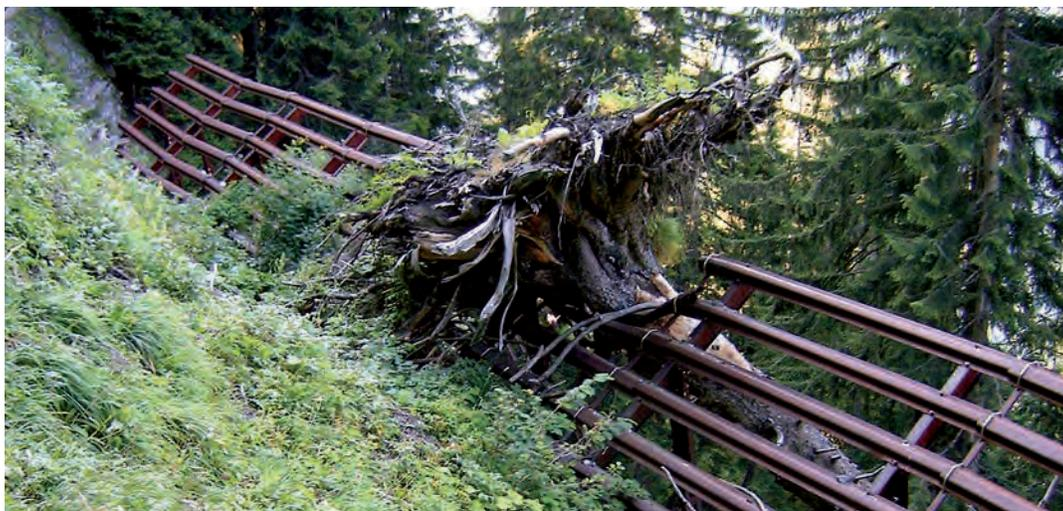
Abbildung 5: Schaden durch Windwurf
