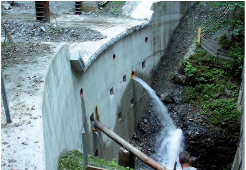
Abb. 5: Ansicht der vorbetonierten Bogensperre nach der Fertigstellung vor Ausführung der Ankerarbeiten.
