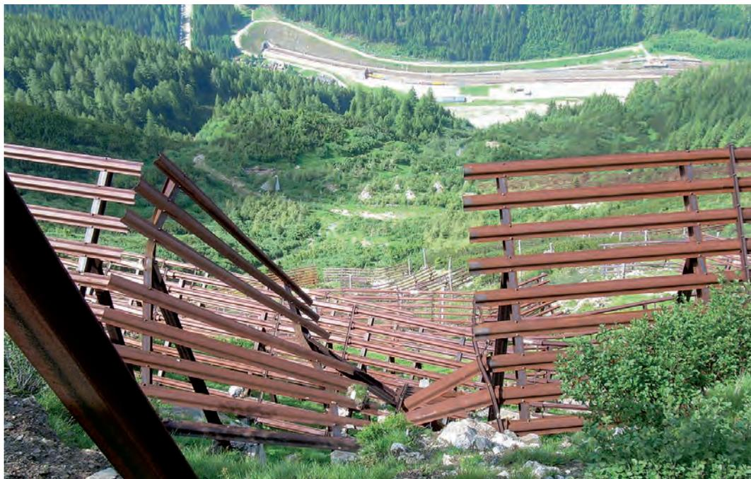
Abb. 3: Zerstörte Schneebrücken am Feuersang bei Bockstein/ Salzburg (Quelle: Wahl, 2005)
