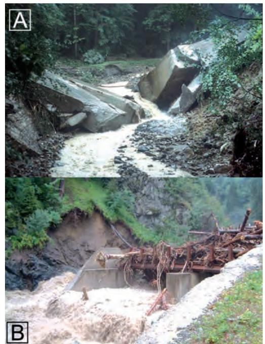
Abb. 4: Schäden an Wildbachsperrern: (A) Verlust der Tragfähigkeit – Totalschaden (Bild: Hannes Hübl); (B) Verlust der äußeren Gebrauchstauglichkeit durch Umgehung (Bild: Walser Otto)
