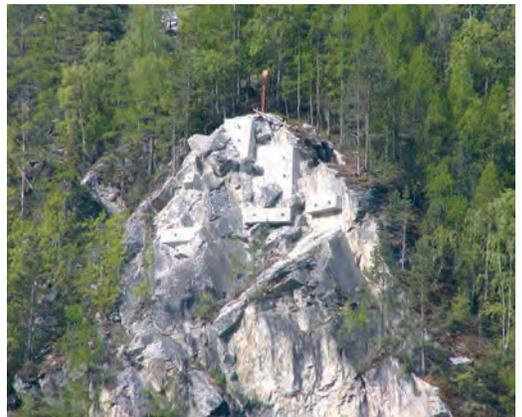
Abb. 4, 5 u. 6: Ankermontage im Steilgelände, Vernetzung und lokale Stützung einzelner Blöcke mittels verankerter Betonpfeiler, Felswand mit Ankerwarzen und Plomben mit Vorspannankern
