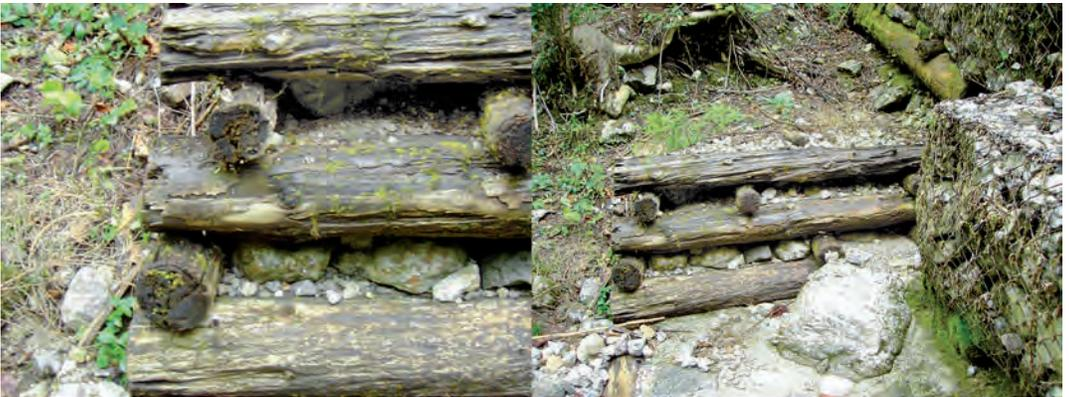
Abb. 26: Moderfäule aufgrund ständiger Durchfeuchtung (Baujahr 1975)
