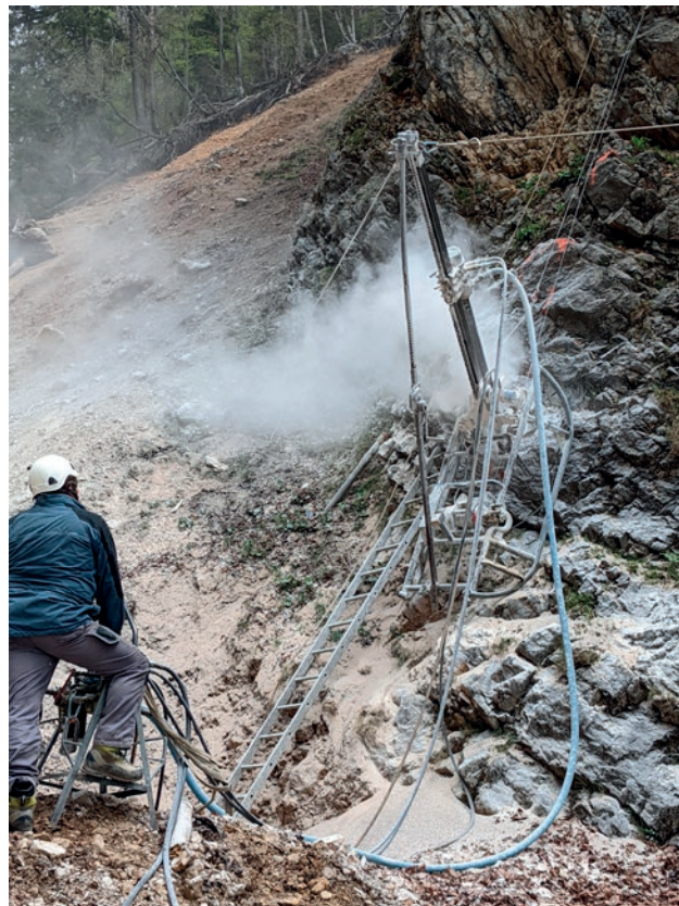
Slika 25: Gradnja pregrade na Lukenjskem grabnu
