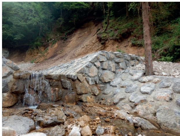
Slika 22: Saniran usad, ustalitveni prag
