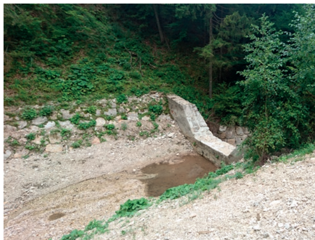
Slika 8: Obstoječa zaplavna pregrada na sotočju Lukenjskega in Brezovškega grabna
