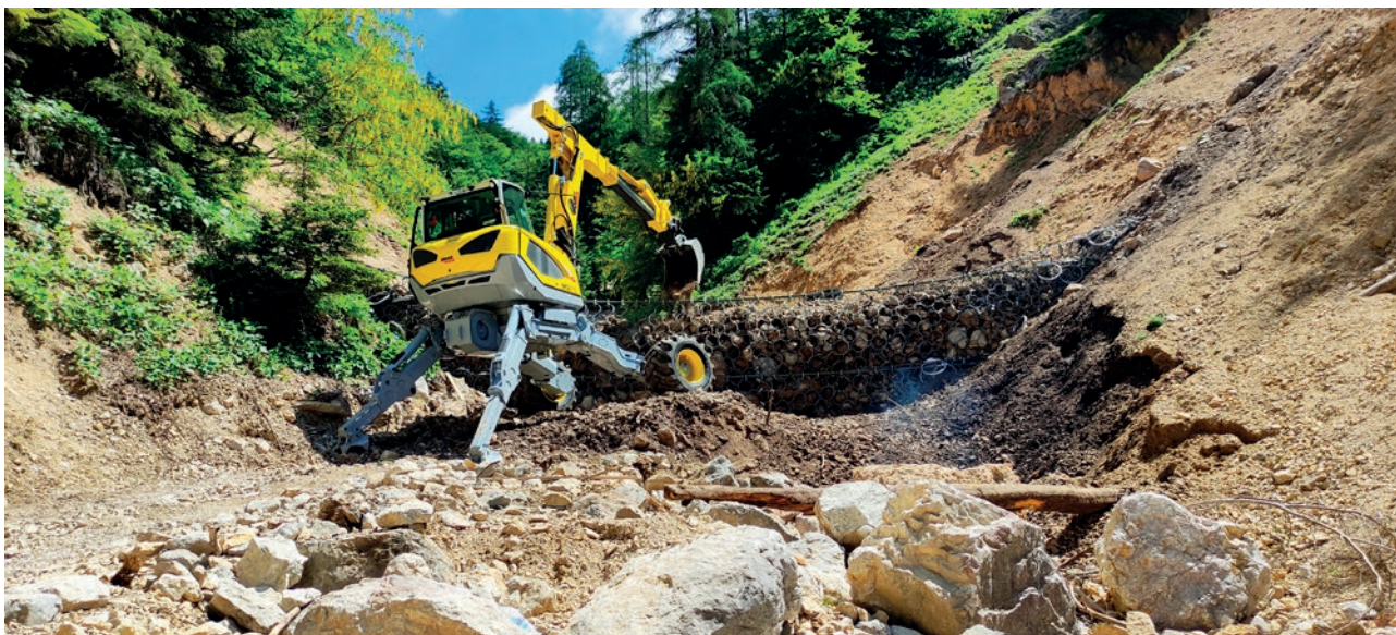
Slika 24: Gradnja pregrade na Lukenjskem grabnu
