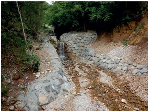
Slika 23: Ureditve na območju objekta vodovoda
