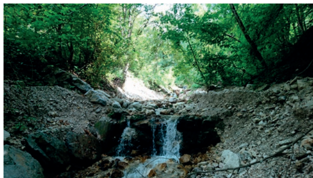
Slika 6: Poškodovana regulacija potoka Reka
