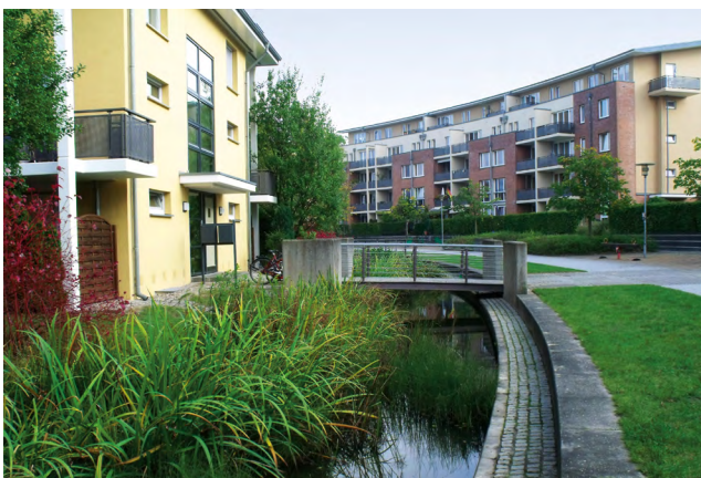
Abb. 56: Wohnpark Trabrennbahn Farmsen mit Regenwasserkanal
