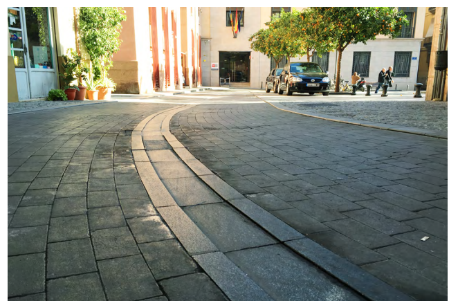
Abb. 89: Historische Altstadt Valencia mit Entwässerungsrinnen
