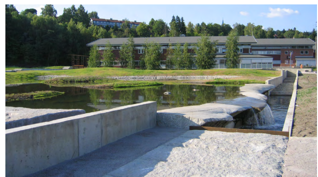
Abb. 45: Naturschwimmteich mit Retention und Überlauf
