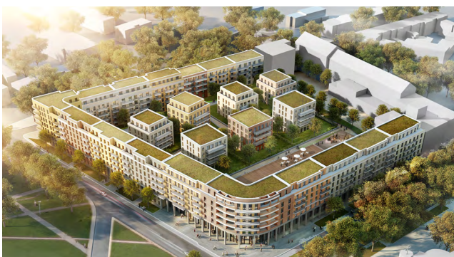
Abb. 75: Dachflächen im Goethequartier in Offenbach
