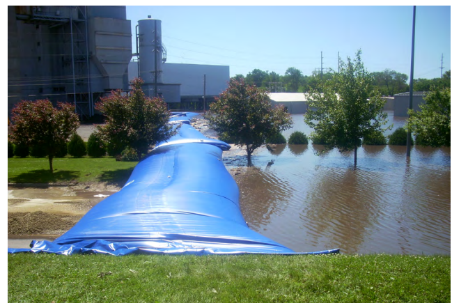
Abb. 93: Mobiler, mit Wasser gefüllter Schutzdamm
