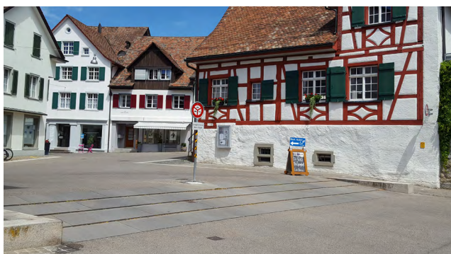
Abb. 33: Schwelle eingangs Altstadt zur Umleitung des Oberflächenabflusses in Steckborn
