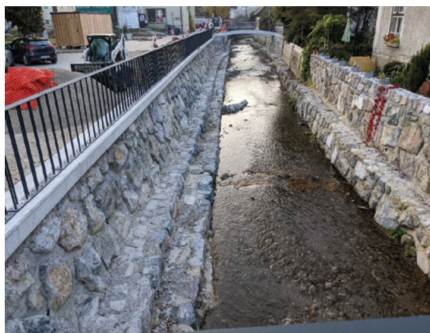
Slika 12: Končno stanje struge Ločivnice, nova ločna brv, stopnice za dostop do vode
