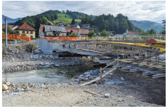
Slika 25: Opažna konstrukcija za novi most
