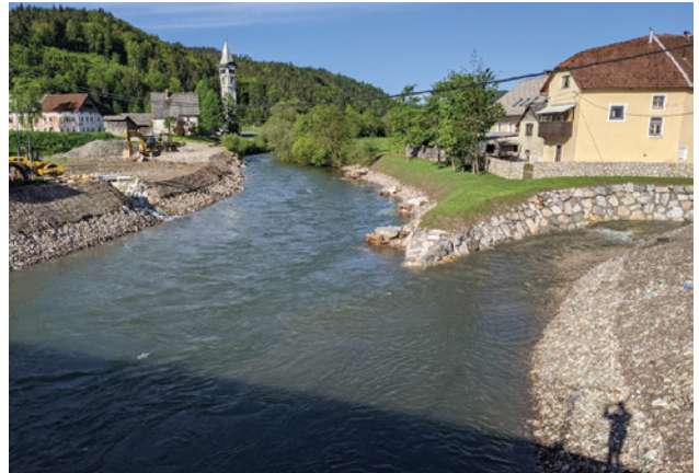
Slika 16: Ureditev sotočja Ločivnice in Sore (pogled z mostu gorvodno)
