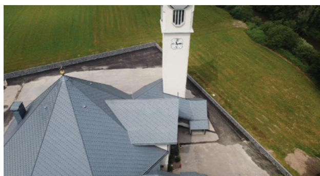
Slika 22: Protipoplavni zid ob cerkvi. AB konstrukcija obložena s kamnom.
