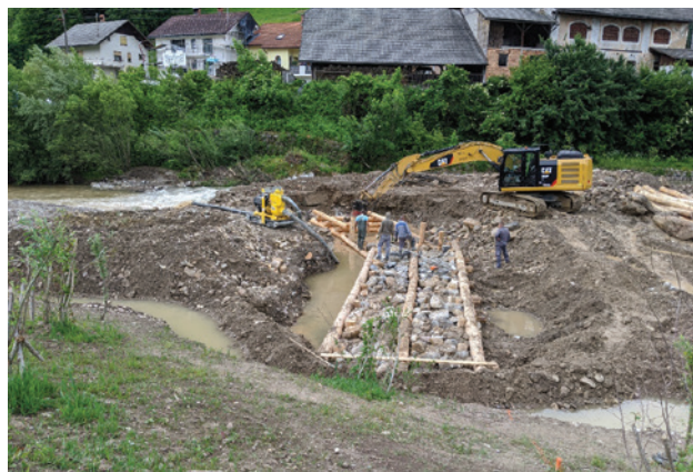
Slika 20: Gradnja pragu iz lesenih kašt pod sotočjem s Hotoveljščico
