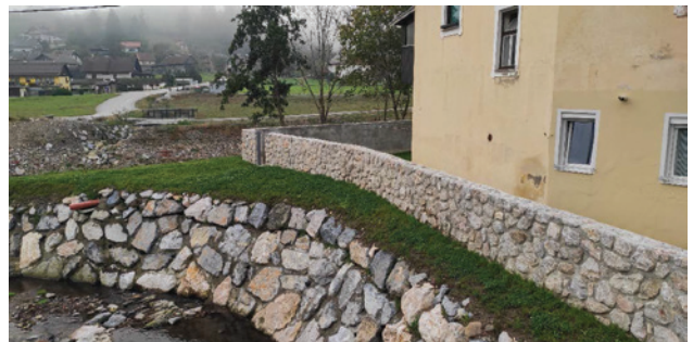
Slika 17: Protipoplavni zid na sotočju za zaščito objektov
