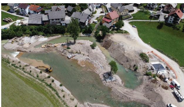
Slika 19: Območje Sore na sotočju s Hotoveljščico – faza gradnje
