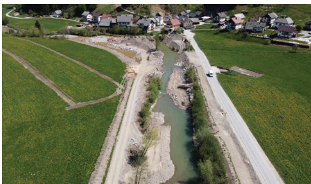
Slika 18: Območje Sore na sotočju s Hotoveljščico – potek stare struge med gradnjo
