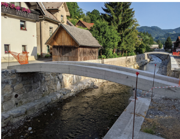
Slika 28: Novi premostitvi na Ločivnici – ločna oblika za povečanje pretočnega profila
