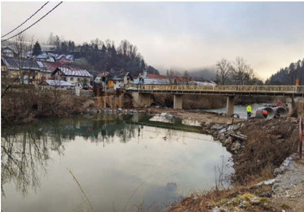
Slika 23: Začasni dostop preko Sore, gradbena jama za opornike in vgradnjo pilotov
