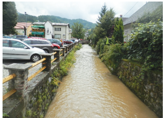
Slika 1: Struga Ločivnice pred izvedbo protipoplavnih ukrepov. Širina prečnega prereza struge je poddimenzionirana in spremenljive širine, mostovi pa so poddimenzionirani.
