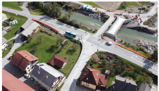
Slika 27: Pogled na gradbišče med gradnjo (stari in novi most)
