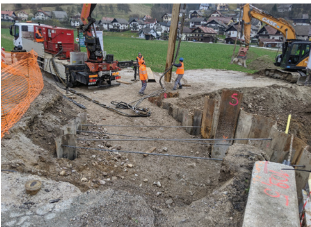
Slika 24: Dodatno sidranje zagatnic za zaščito prevoznosti starega mostu med gradnjo
