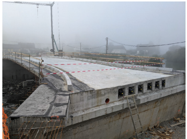
Slika 26: Konstrukcija novega mostu, napeljalni kabli – glave
