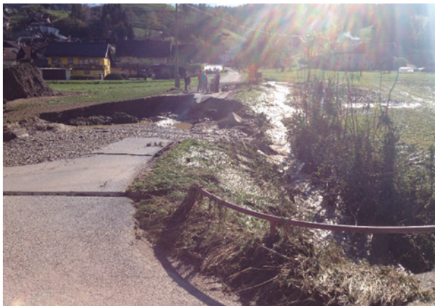
Slika 2: Cesta za Predmost poškodovana v poplavih leta 2014.
